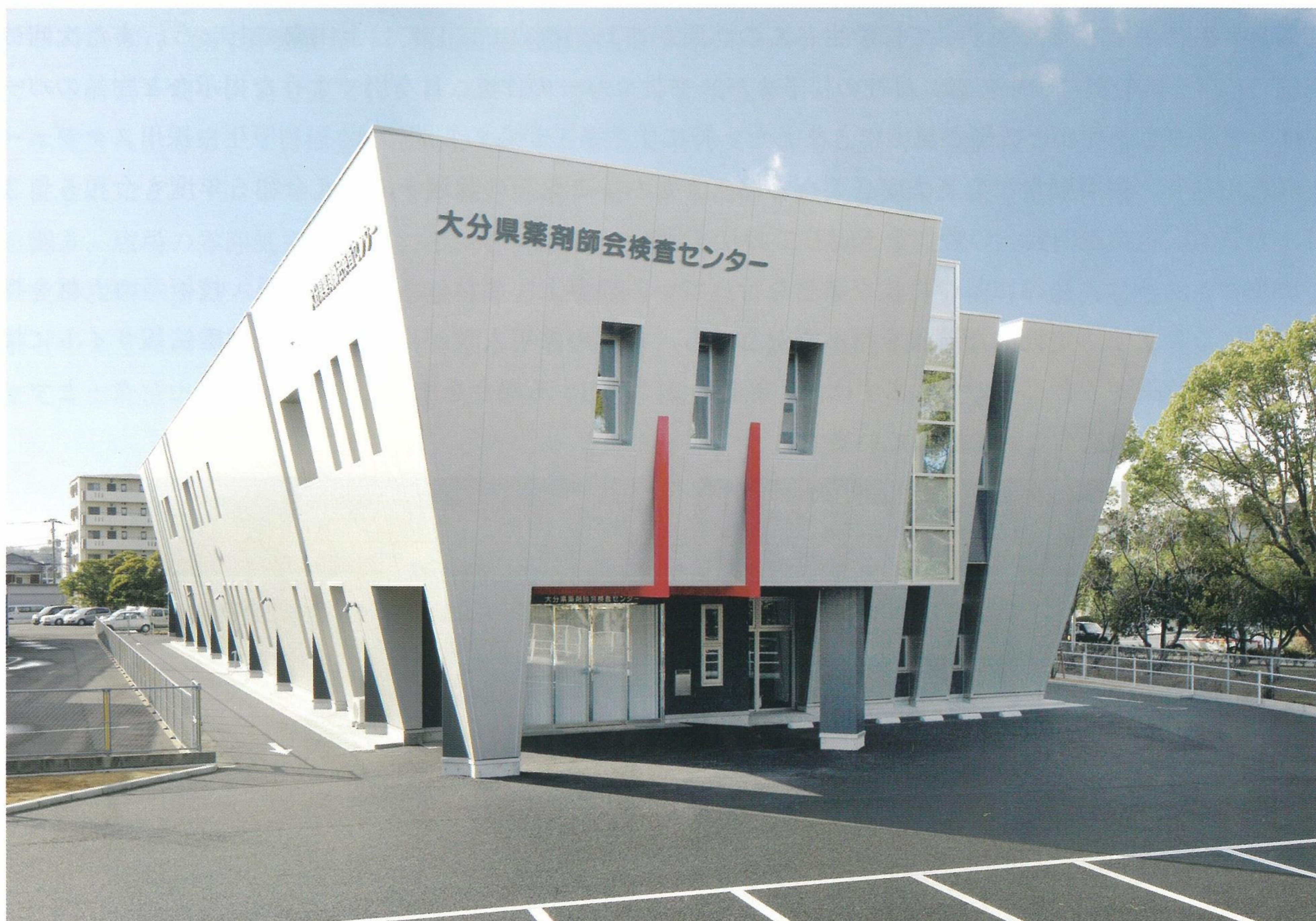
検査センター
